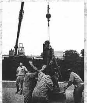
9 搬移及安裝大型物件
